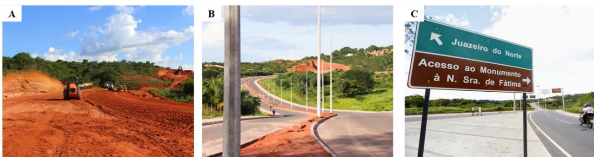
FIGURA 4: Antes e depois das modificações realizadas no relevo para abertura da avenida Dom Vicente de Paula Araújo Matos, Crato-CE.
